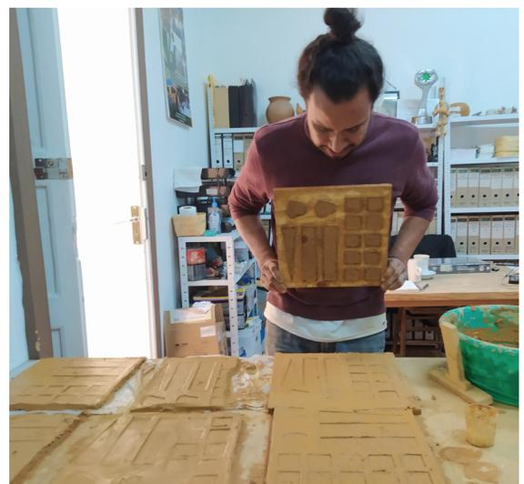
fina de 5 mm de espesor sobre el repello grueso y posteriormente estampar el sello para lograr los bajo relieves. Los resultados no fueron atractivos debido a que la mezcla se secaba rápidamente y por otro lado no se lograba una profundidad homogénea en los estampados.
